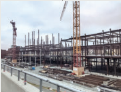
Local 764 ironworkers and welders erect Core Science Building at St. John's Memorial University. // Les travailleurs des métiers de l'acier et les soudeurs de la section locale 764 montent le Core Science Building de l'Université Memorial de Saint-Jean.
