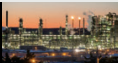
Local 842 ironworkers at Irving Oil's Refinery Tier 3 project. // Les travailleurs des métiers de l'acier de la section locale 842 sur le projet de catégorie 3 de la raffinerie d'Irving Oil.
